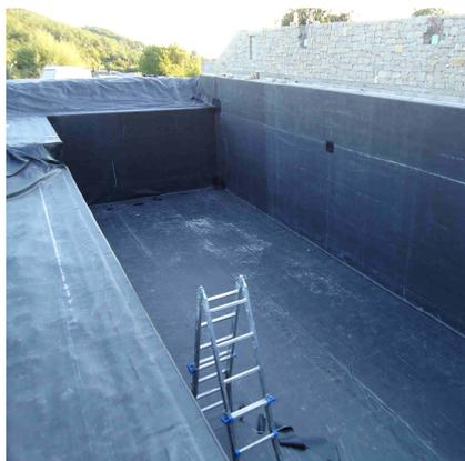
EPDM Kautschukfolien werden aus synthetischem Kautschuk hergestellt, sind außerordentlich resistent gegen UV-Strahlung, Ozon, Frost, Schnee und extremen Temperaturen. Die Folie enthält keinerlei Weichmacher, was bedeutet, dass sie weder rissig noch spröde wird.
